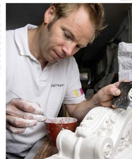
Eine schnelle und doch exakte Arbeit: Nur zwanzig Minuten bleiben dem Experten, um den flüssigen Gips zu verarbeiten – dann setzt sich dieser ab.
